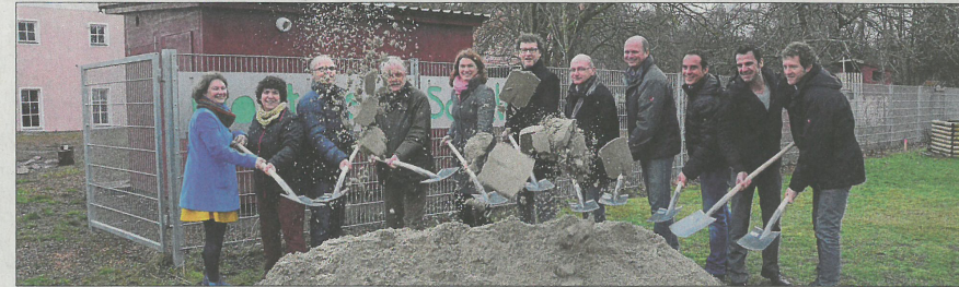
Am Dienstagnachmittag erfolgte im Beisein einiger Ehrengäste, voran von Landrätin Tanja Schweiger, der offizielle Spatenstich für das neue Kinderhaus des Montessori-Fördervereins, wobei die Fertigstellung zum 1. September 2016 geplant ist. (Fotos: Neumann)
